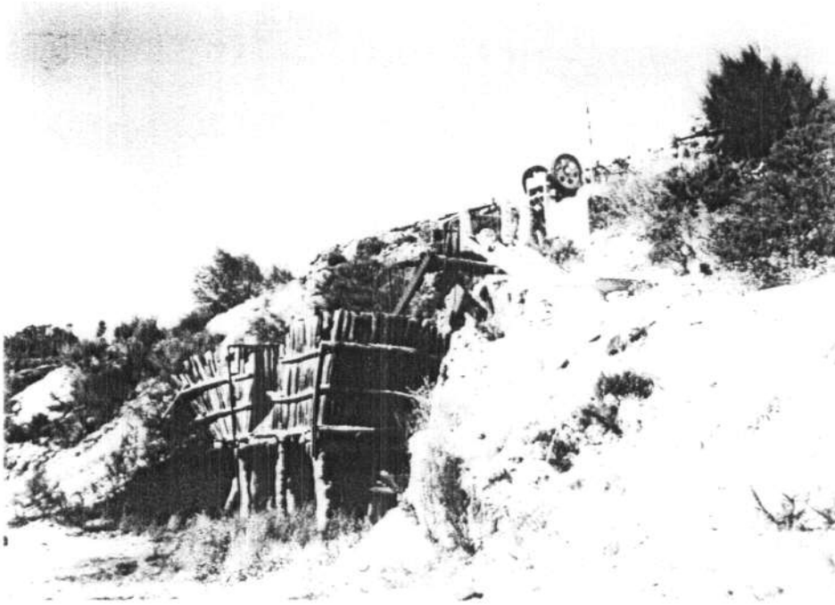
Vista actual de la explotación, en total abandono. Durante su funcionamiento, la producción se destinó a áridos de trituración para obras de infraestructura. (Cercanías de Forja). Estación 2-3 RN-136.
