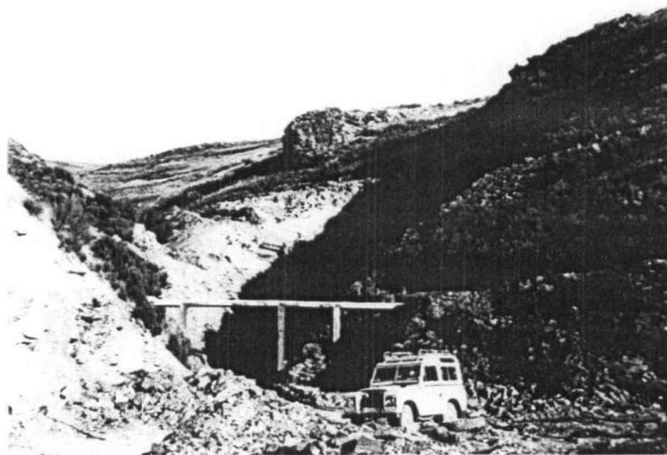
Explotación activa de pizarra de techar, al N de San Vicente de Leira. La explotación presenta como dificultad una importante cobertera de material pizarroso no aprovechable. Estación 3-3/RN-98.
