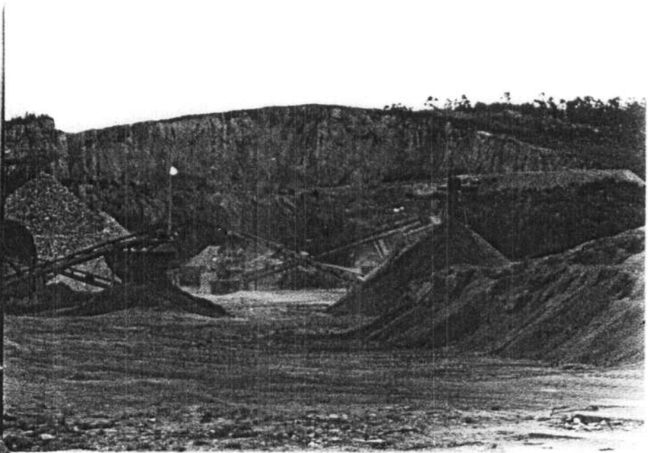
Cantera de granito y parte de las instalaciones. (La Coruña). Estación 2-2 / AH-4.
